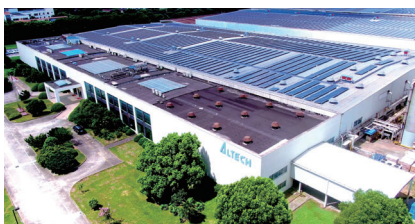
愛而泰可新材料 蘇州工場 (6MWの発電設備)
